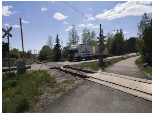
Kuva Heinämaantien tasoristeys Lahti-Loviisa radalla on suojattu puomilaitoksella.
