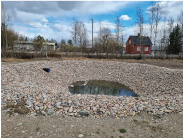
Kuva Suojaviheralueen hulevesialtaasta, taustalla Heinämaantie.
