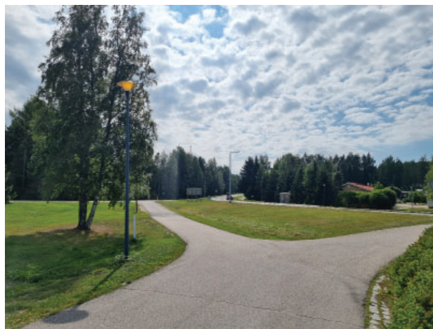
Hyväkuntoinen jalankulku- ja pyöräilyväylä Helsingintien pohjoispäässä.
