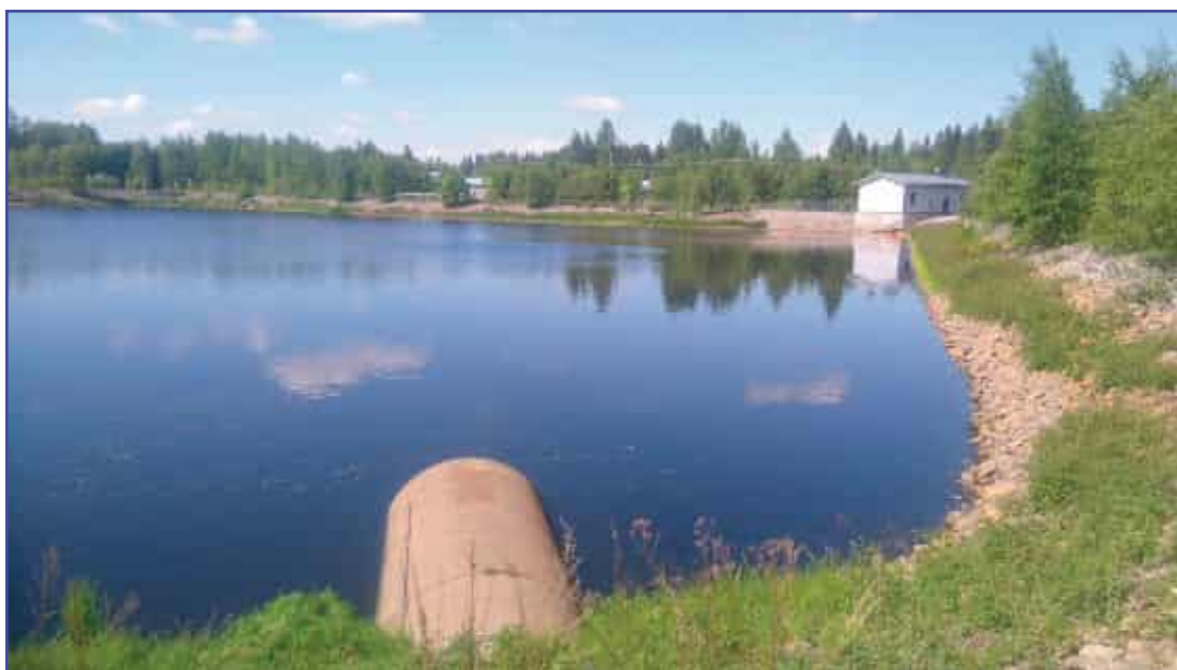
Kuva 2. Lahden Kariniemen ja Ali-Juhakkalan jätevedenpuhdistamoiden tasausallas ja UV-hygienisointilaitos kuvan oikeassa yläkulmassa.
