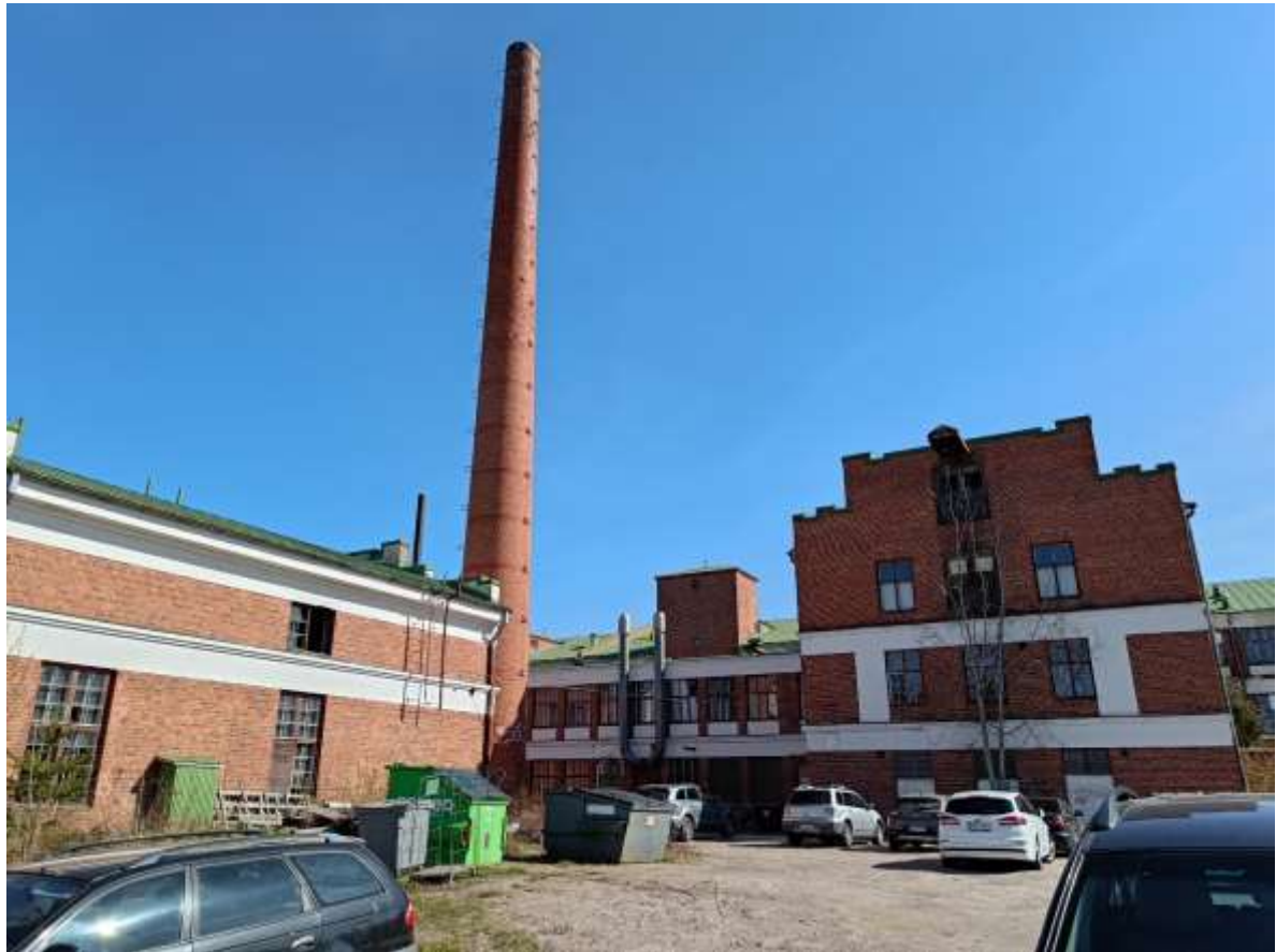
Kuva 14. Näkymä Kehräämön sisäpihalta.
