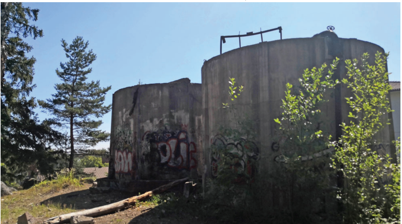
Kuva. Tullinpuiston vanha vesitorni.
