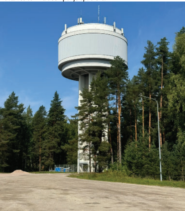
Kuva. vesitorni alueen pohjoispuolella.
