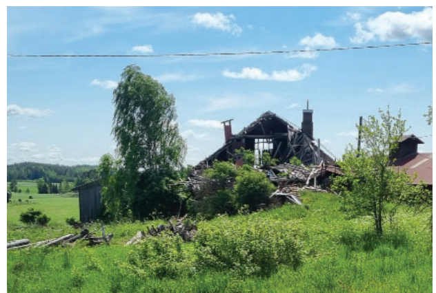
Kuva. Käytöstä poistunut Uotilan tilakeskuksen talousrakennus Lankilantien eteläpuolella.
