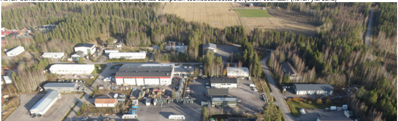
Kuva. Asemakaavan muutoksen tavoitteena on laajentaa Sampolan teollisuusaluetta pohjoisen suuntaan (kuvan yläreuna)
