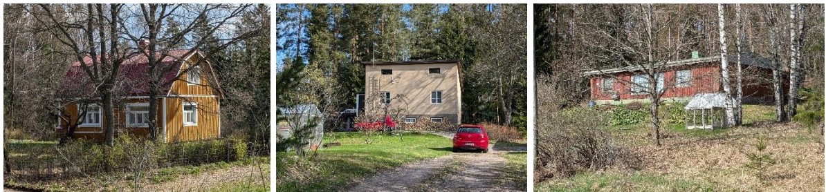
Kuva 3-33. Vanha Lahdentien rakentamista eri vuosikymmeniltä. Vasemmalla 1920 valmistunut Vanha Lahdentie 89, keskellä 1937 valmistunut Haikulantie 5 ja oikealla 1971 valmistunut Vanha Lahdentie 78. Maakunnallisesti arvokkaaseen rakennettuun kulttuuriympäristöön kuuluu näistä rakennuksista 1970-luvulla valmistunut asuinrakennus.
