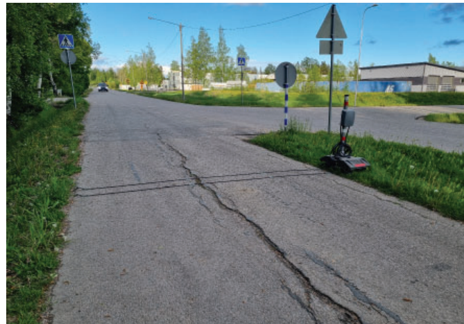
Kuva. Mittalaite kävely- ja pyöräilytien päässä
