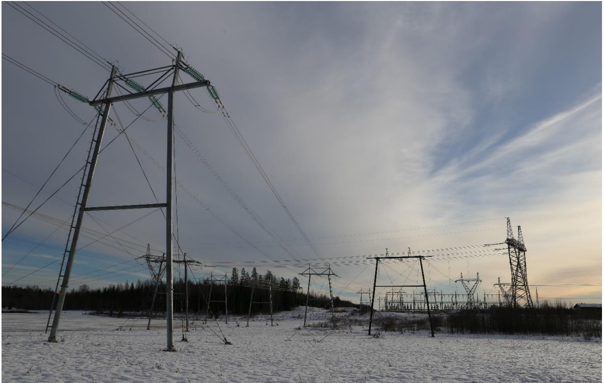
Kuva 3-22. Voimajohtomaisemaa suunnittelualueen kaakkoisosassa kuvattuna Rautamäentieltä kohti etelää ja Fingridin sähköasemaa.
