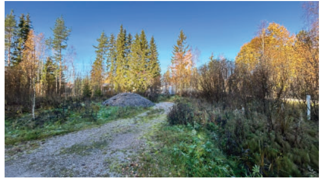
Kuva. Takojantien ja Teollisuustien risteys; pumppuasema.
