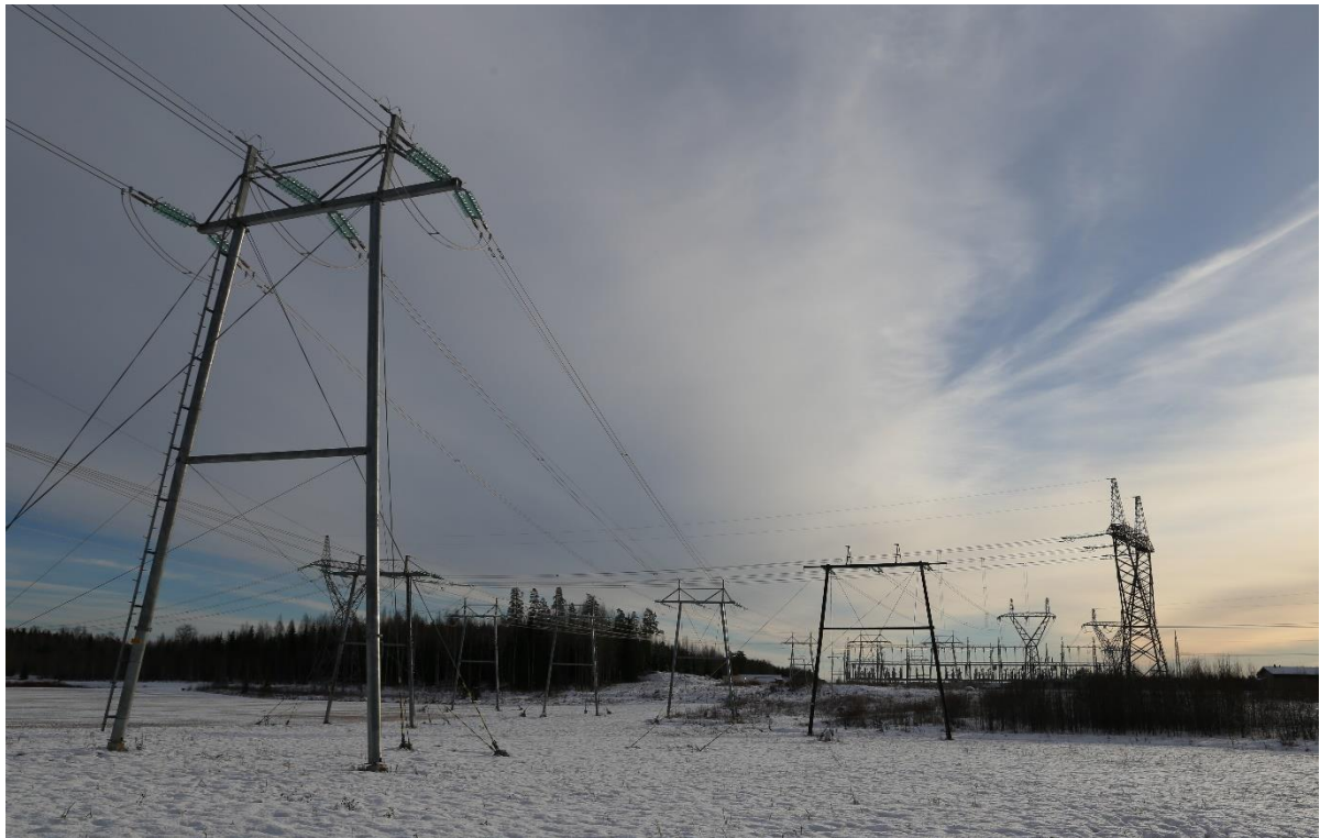
Kuva 4-26. Voimajohtomaisemaa suunnittelualan kaakkoisosassa kuvattuna Rautamäentietä kohti etelää ja Fingridin sähköasemaa.
