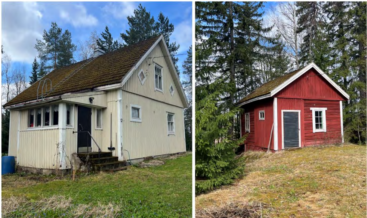
Kuva 4-3. Aittomäen päärakennus ja mökki.
