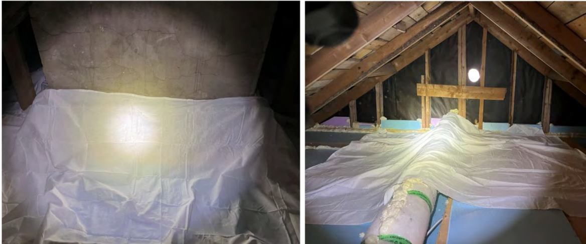
Kuva 4-6. Uutelan päärakennuksen ullakolle huhtikuussa 2025 levitetyt lakanat.
