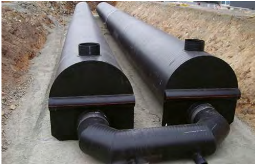
Kuvat 17. Esimerkki tonttikohtaisesta suuremman mittaluokan hulevesisäiliöstä hulevesien viivytykseen ja varastointiin [Weholite, Uponor Oyj].
