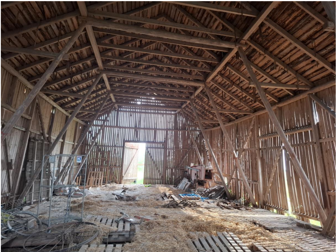
Kuva 3.2. Lato A kuvattuna sisältäpäin.
