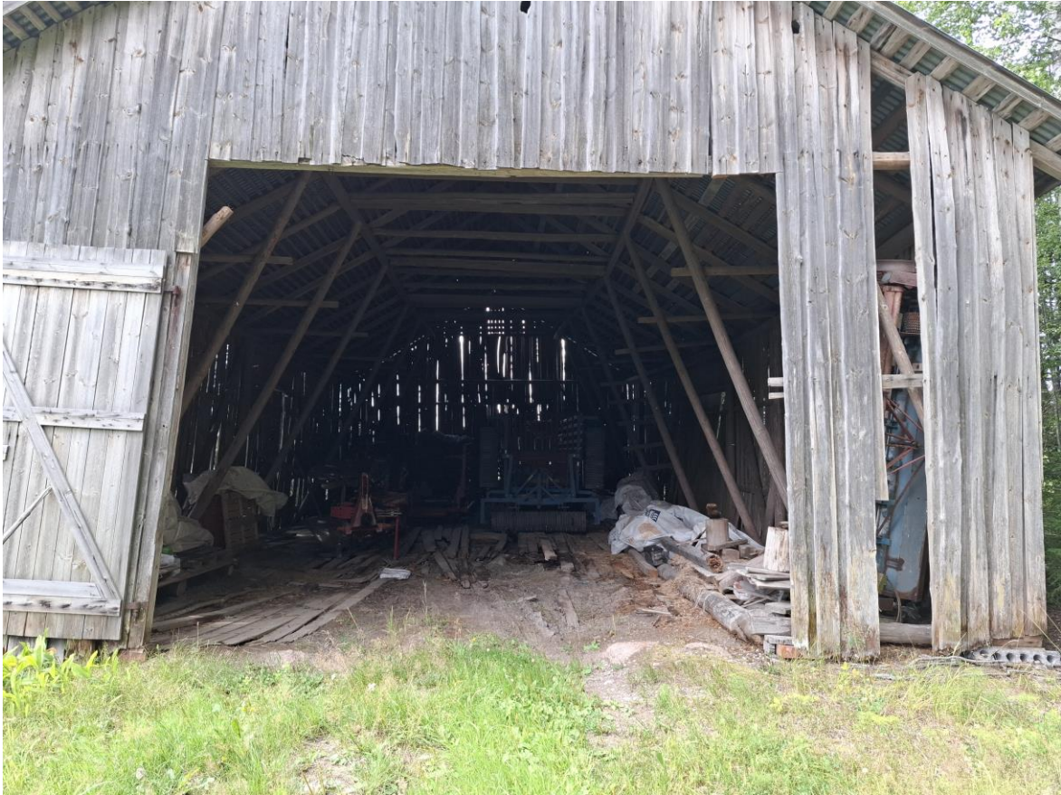
Kuva 3.3. Lato B kuvattu ulkoapäin.
