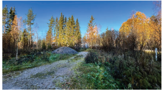
Kuva. Takojantien ja Teollisuustien risteys; pumppuasema.
