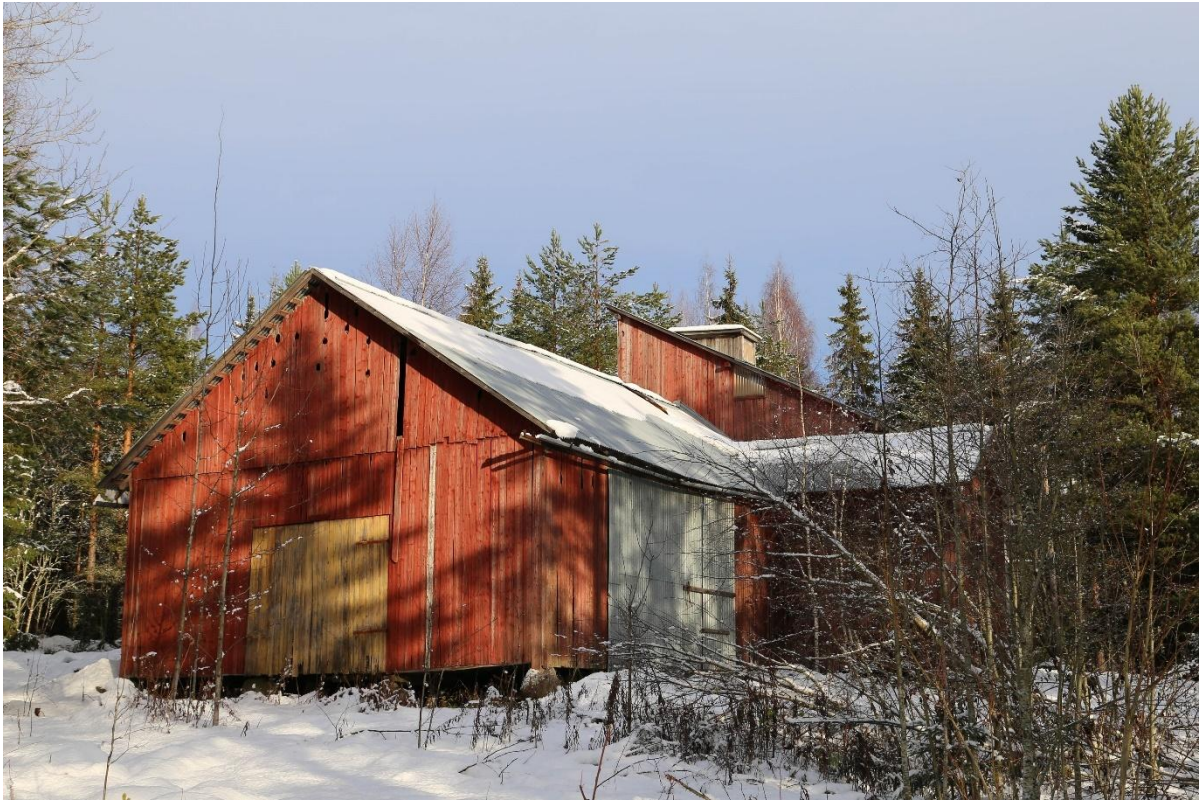
Kuva 4-39. Viljakuivaamorakennus on purettu.
