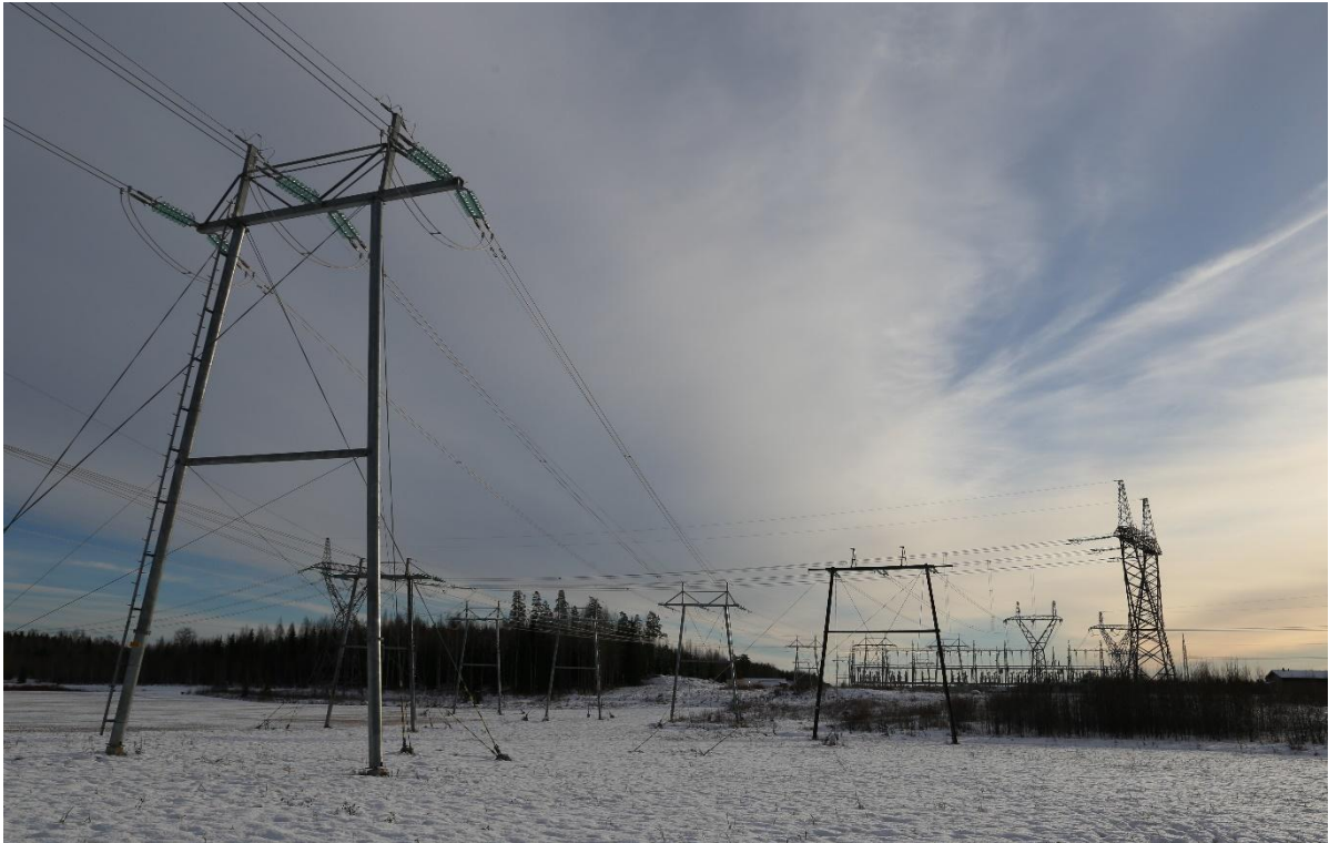
Kuva 4-27. Voimajohtomaisemaa suunnittelualueen kaakkoisosassa kuvattuna Rautamäentieltä kohti etelää ja Fingridin sähköasemaa.
