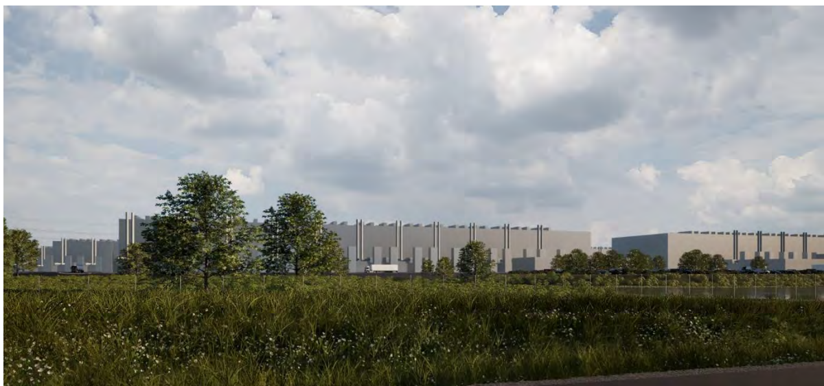
Kuva 8-10 Nykytilan valokuva Pönön peltoalueen laidasta kaakon suuntaan (yllä) ja viitteellinen havainnekuva (alla) datakeskuksen rakennusten ja muiden uusien rakenteiden näkymisestä suunnittelualueelle rakennettavalle Jokimäentielle. Havainnekuva on tehty 3D-mallintamalla. Kuvat on esitetty isompina havainnekuvaliitteessä (liite 5). Havainnekuvan "katselupaikka" (kartalla numero 4) sijaitsee suunnitellulla Jokimäentienellä noin 230 metrin etäisyydellä lähimmästä rakennuksesta. Datakeskusrakennusten edustalla näkyy katuviheraluetta, hulevesiallas, pysäköintialuetta ja datahalleja matalampia toimisto- ja oheis-/ tukitoimintojen rakennuksia.
