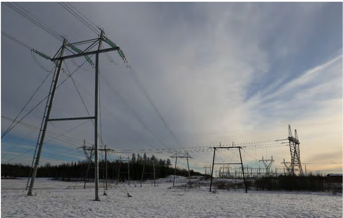
Kuva 3-26. Voimajohtomaisemaa suunnittelualueen kaakkoisosassa kuvattuna Rautamäentieltä kohti etelää ja Fingridin sähköasemaa.
