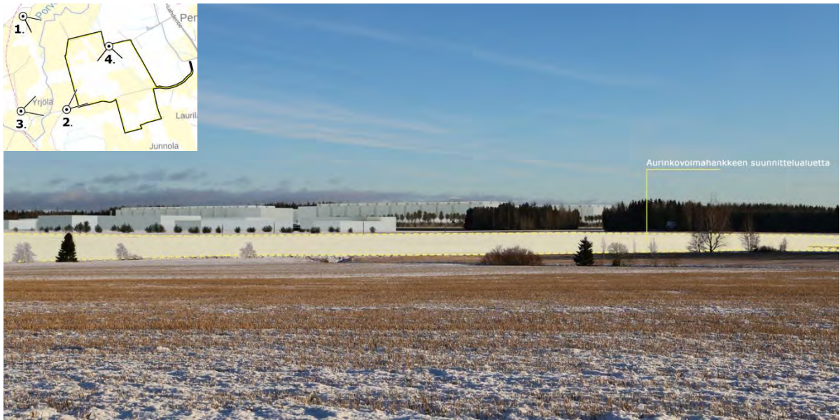
Kuva 9-1 Viitteellinen havainnekuva nro 1 datakeskuksen rakennusten ja muiden uusien rakennusten näkymisestä suunnittelualueen luoteispuolelle. Havainnekuva on tehty valokuvasovitteena. Kuva on esitetty isompana havainnekuvaliitteessä, liite 5. Kuvauspaikka (kartalla numero 1) sijaitsee Ojalantiellä, noin 870 metriä suunnittelualueesta luoteen suuntaan. Teollisuus- ja yritystonttien rakennuksia (asemakaavassa T-3-alue) sekä datakeskuksen pohjoisimpia rakennuksia näkyy laajasti Porvoonjoeka ympäröiville peltoaukeille. Kaavan suunnittelualueen pohjoispuolelle sijoittuvan aurinkovoimahankkeen aluevaraus on esitetty havainnekuvasssa aluemaisella merkinnällä.
