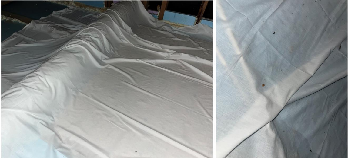
Kuva 4-10. Uutelan päärakennuksen ullakolle sijoitettu lakana elokuussa 2025.
