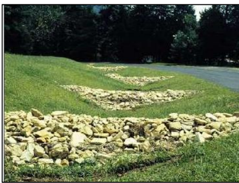
Kuva 26 Esimerkki ojatkosta (Virginia Stormwater Management Program) ja tyyppileikkaus huoltoteiden yhteyteen rakennettavista viherpainanteista.
