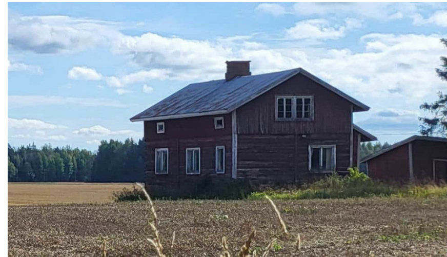
Kuva 20 Ojalan vanhempi päärakennus maiseman yllä. (Kts. myös havainnekuva)
