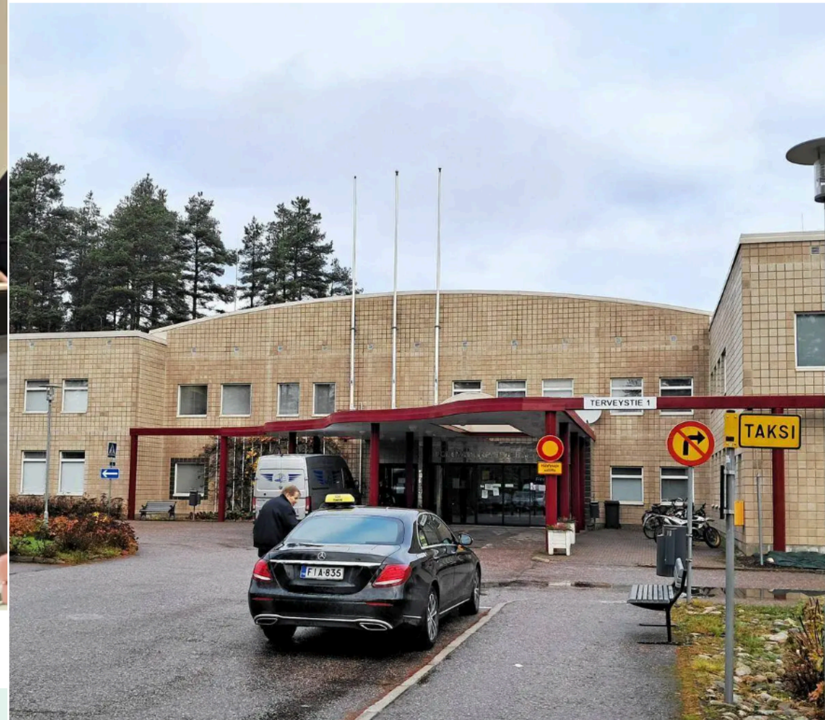
Laki velvoittaa kuntia tietyin edellytyksin yhtiöittämään terveysasemia. Tätä valmisteltiin myös Orimattilassa, mutta vuonna 2021 valmistuneen soite-aseman kiinteistö jää toistaiseksi myymättä. Kuva on lokakuulta. JANNE URPUENEN
