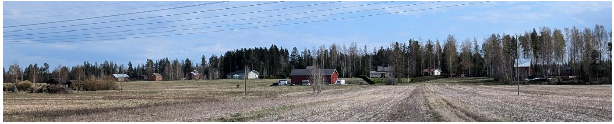
Kuva 3-35. Haikulan rakentamista. Kuvassa vasemmalla näkyy Rinteen punainen 1951 valmistunut päärakennus ja vasemmalla Päivärinnan 1947 valmistunut päärakennus. Välissä on uudempaa rakentamista.
