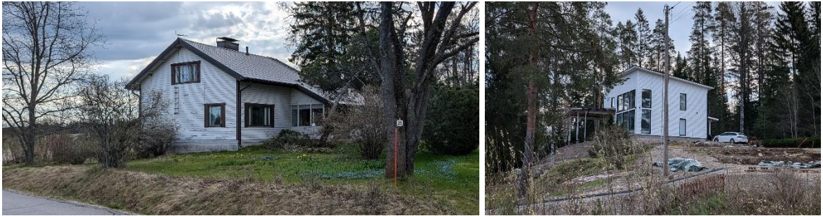
Kuva 3-40. Kuivistonmäen pohjoispuoleista rakentamista. Vasemmalla Pennalantie 26 ja oikealla Kuivistonmäki 6.
