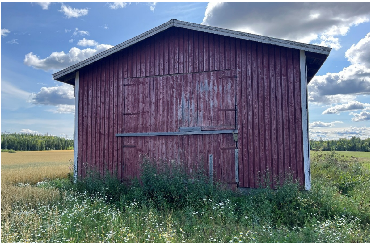
Kuva 1-3. Lepakkoselvityksen kohteena oleva varastorakennus.
