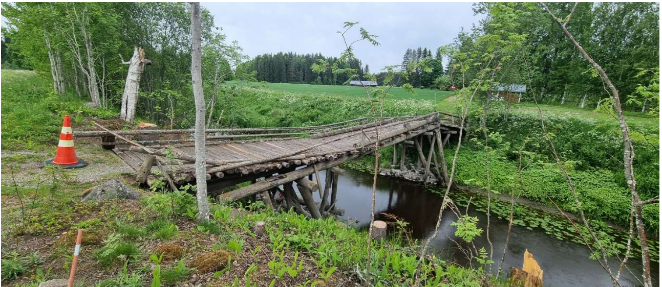
Kuva 4. Hankealueen pohjoispuolella on vanha puinen silta. Luoteeseen.
