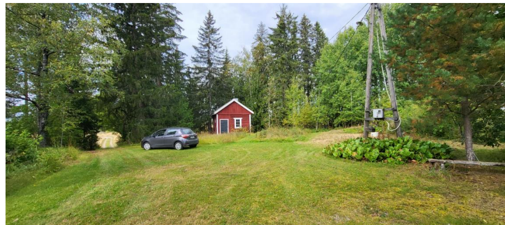
Kuva 17 Näkymä päärakennukselta luoteeseen ja pohjoiseen on sulkeutunut.
